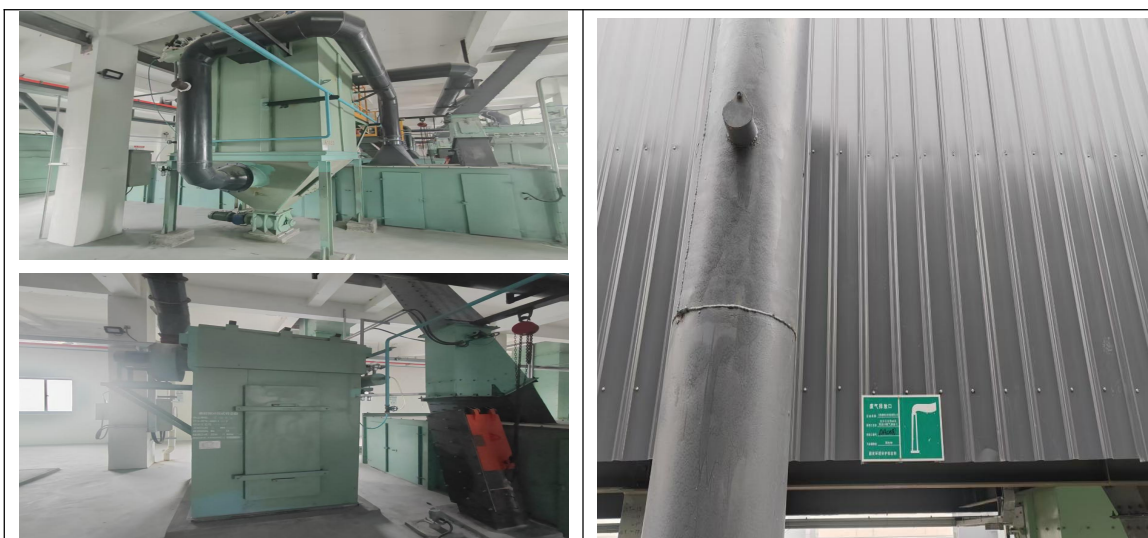
白云石仓顶 1#、3#袋式除尘+34m 排气筒（DA019）
