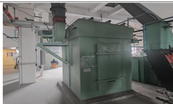
干法脱硫+复合陶瓷滤筒脱硝除尘一体化+98m 排气筒（DA001）
