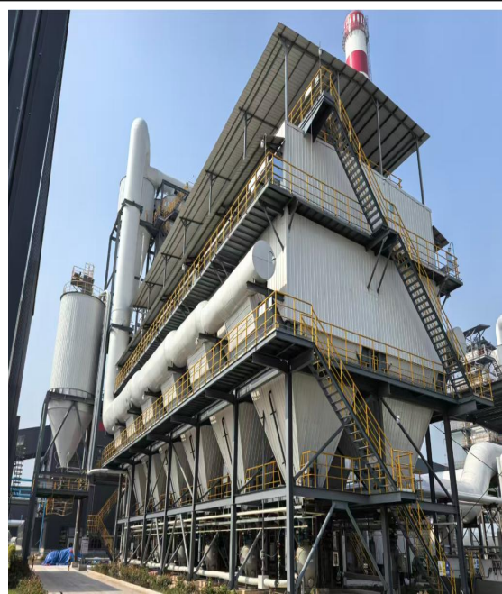
干法脱硫+复合陶瓷滤筒脱硝除尘一体化+98m 排气筒（DA001）
