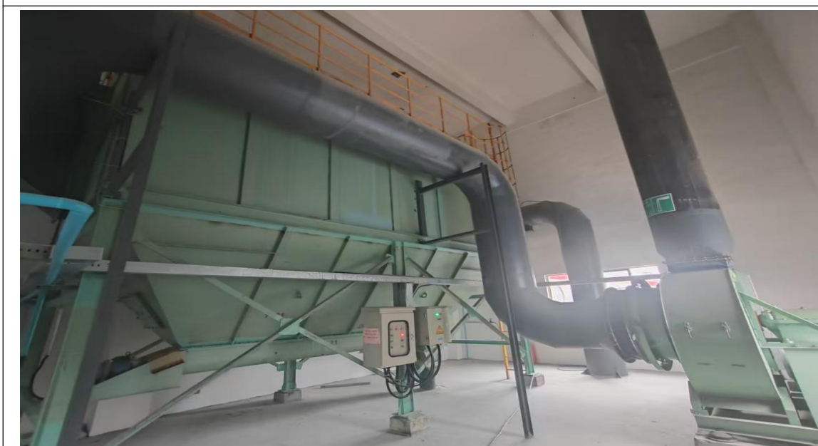
1#外加碎玻璃转运楼袋式除尘+17m 排气筒（DA034）
