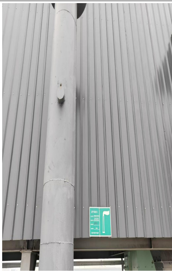
石灰石仓顶 2#及转运 1#袋式除尘+34m 排气筒（DA017）
