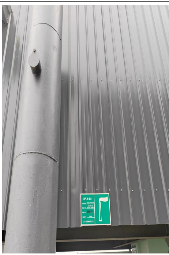
纯碱仓顶 4#及转运 2#袋式除尘+34m 排气筒（DA016）
