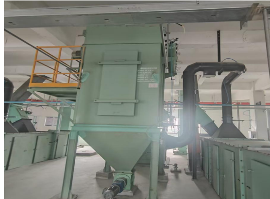
纯碱仓顶 4#及转运 2#袋式除尘+34m 排气筒（DA016）
