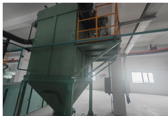
石灰石仓顶 4#及转运 2#袋式除尘+34m 排气筒（DA0018）
