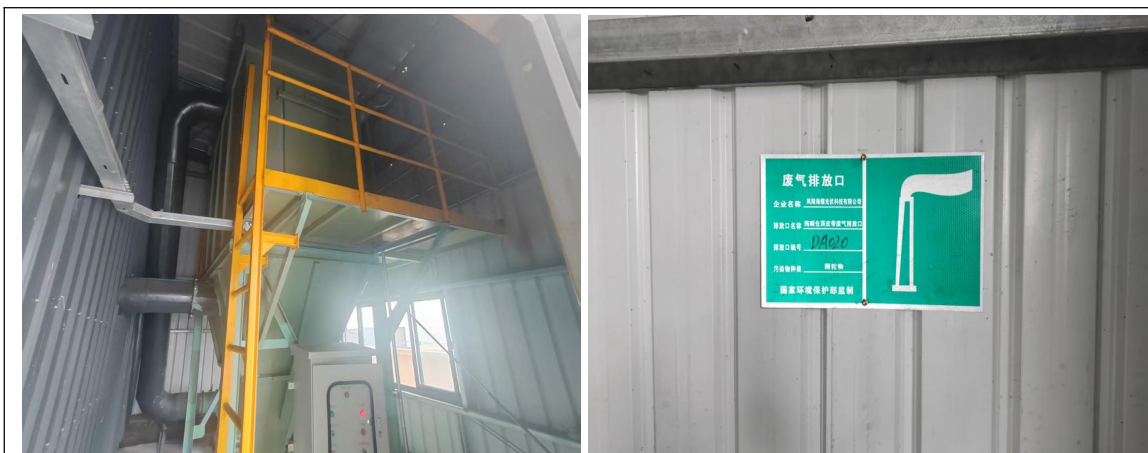
纯碱仓顶皮带袋式除尘+34m 排气筒 (DA014)
