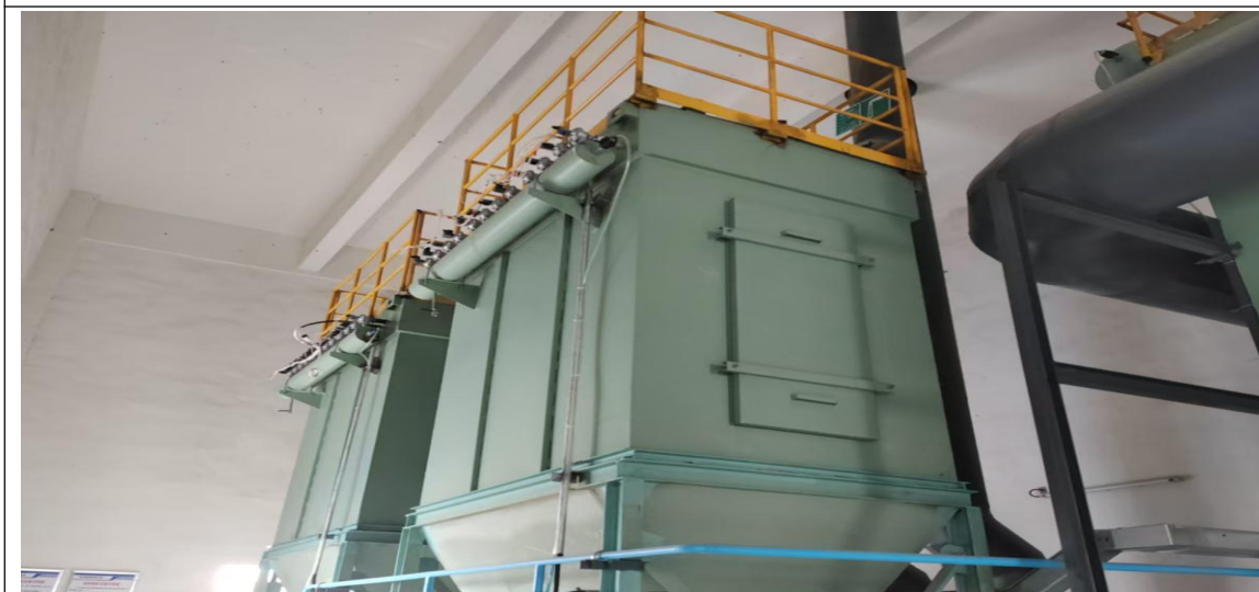
1#碎玻璃转运楼 2#袋式除尘+17m 排气筒（DA033）
