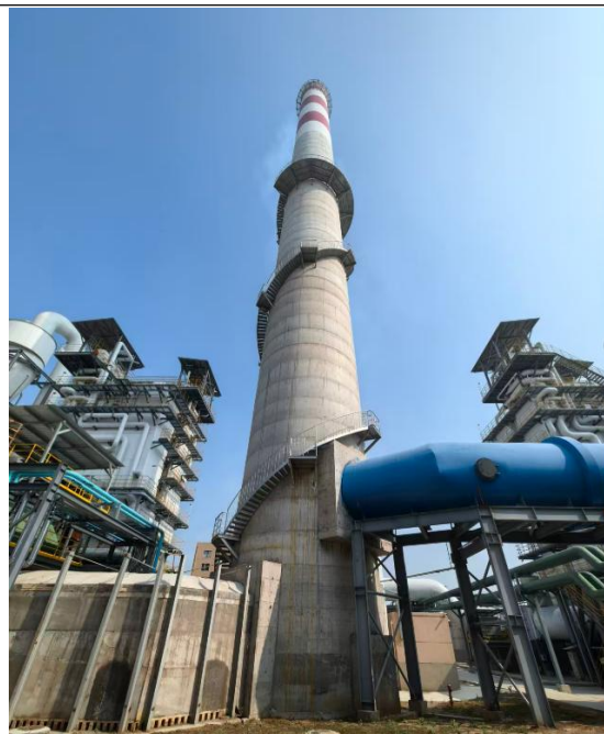
干法脱硫+复合陶瓷滤筒脱硝除尘一体化+98m 排气筒（DA001）
