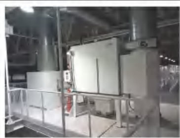
破检室等离子切割滤筒除尘器
