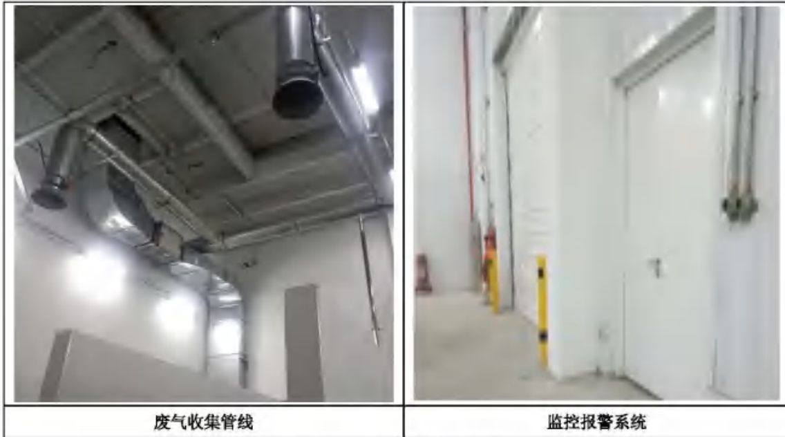
图 4.1-5 危险废物暂存间照片
