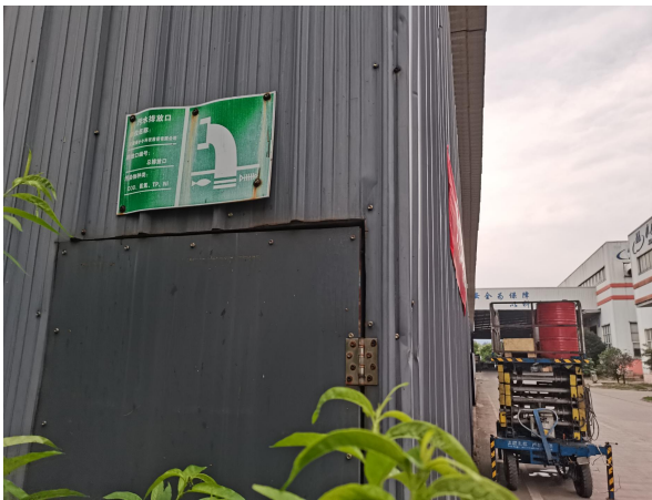
厂区污水处理站
