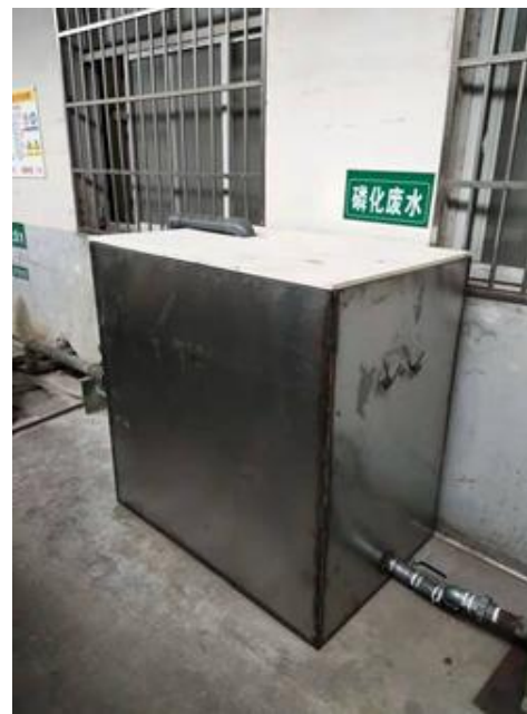
磷化工段塑料中间水池改为钢设备，连接为固定硬管
