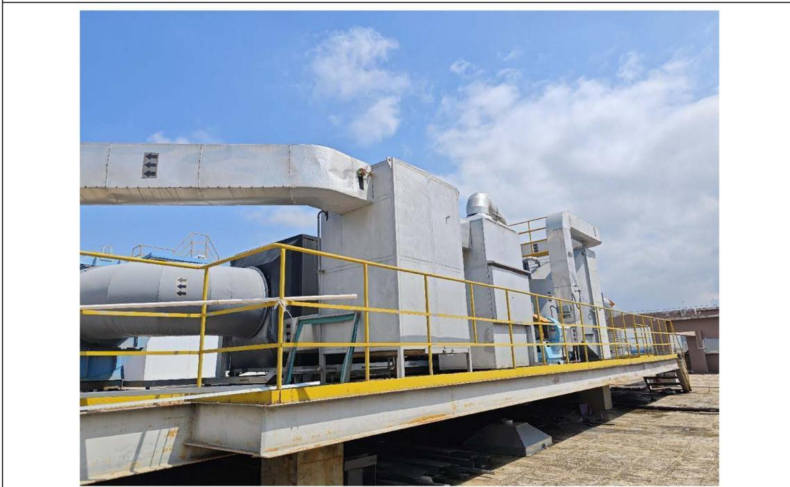
有机废气处理装置主体
