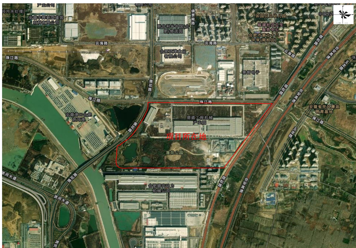
项目所在地 2024 年初历史影响图（项目租赁的厂房准备开工建设，目前主体框架已建成）
