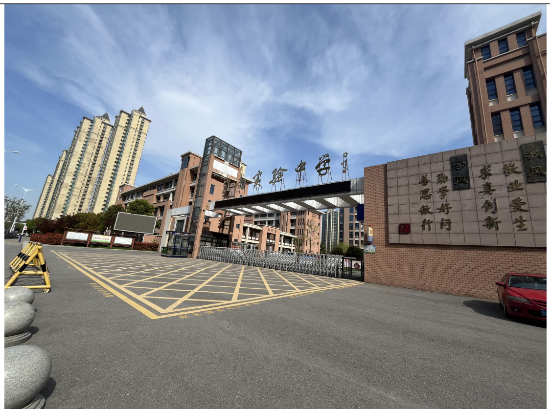
地块南侧现状照片（淮南实验中学山南第一学校）
