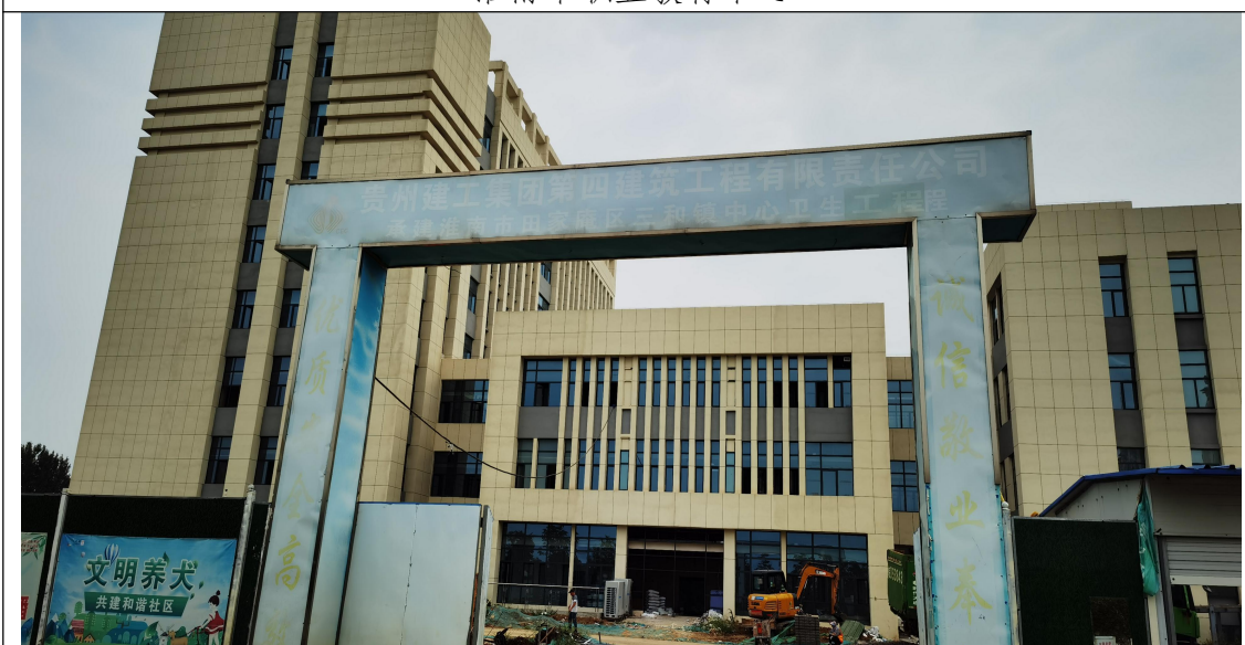
三和镇中心卫生院（在建）
