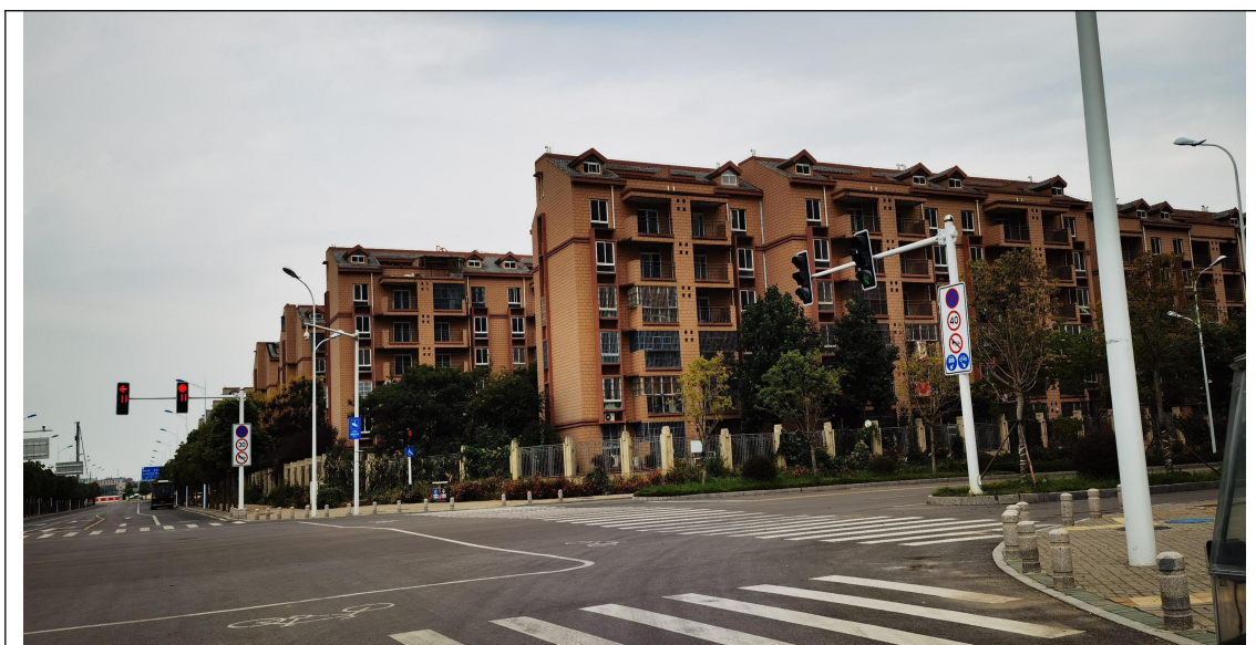
中部地块东侧现状照片（道路、香樟苑小区三期）
