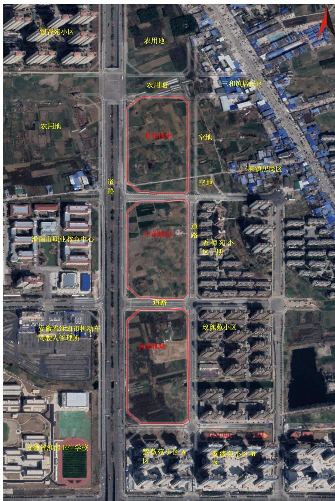
图3.5-1淮南高新区青桐苑北区、中区、南区及附属配套项目地块附近地块现状图
