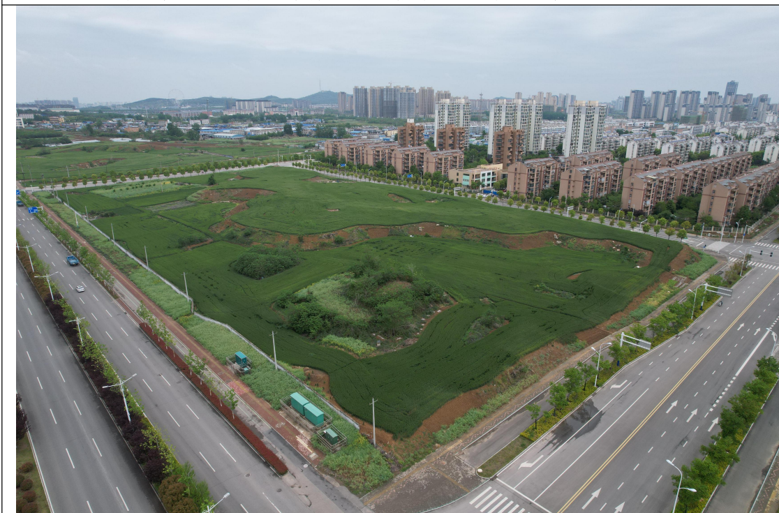
中部地块 2023 年 5 月场地平整前航拍照片（地块主要为空地，西南侧为大孤堆墓遗址，中东部区域堆存的土方来自于东侧香樟苑小区三期建设过程中的开挖的土方，香樟苑小区三期原地块为农用地和村庄，无工业企业存在，目前该地块中东部区域堆存的土方已外运至李郢孜镇采煤沉陷区用于生态修复）
