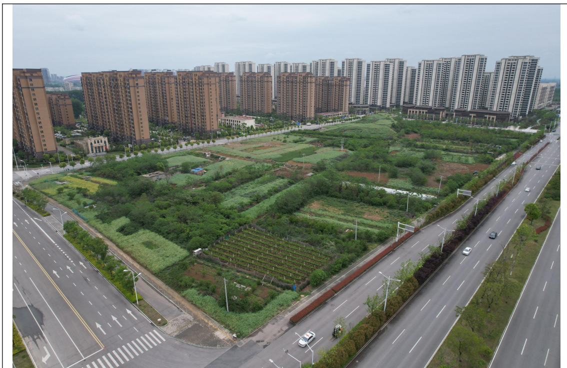
南部地块 2023 年 5 月场地平整前航拍照片（主要为拆迁后遗留的空地和农田）
