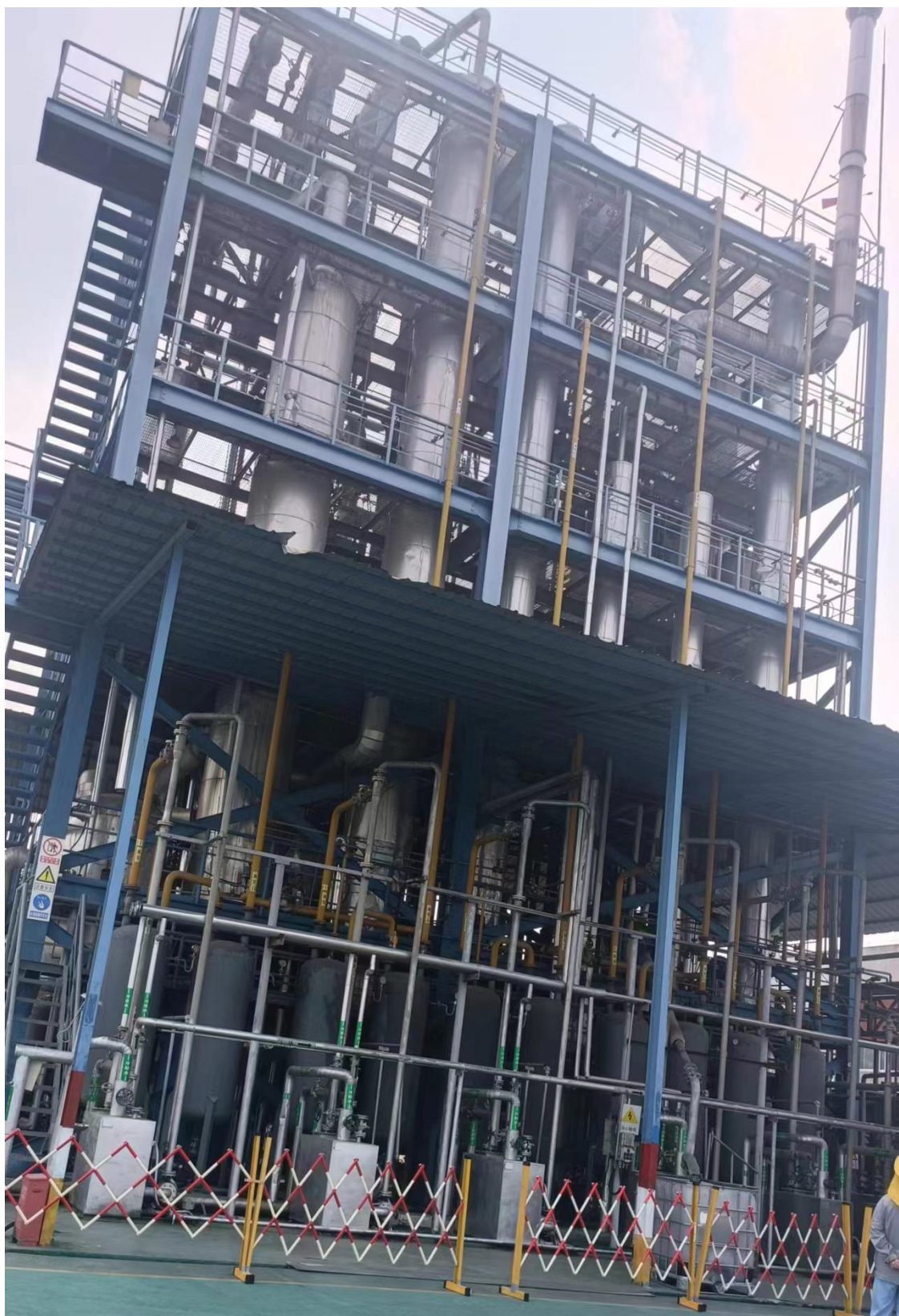
稀释液处理线主体工程
