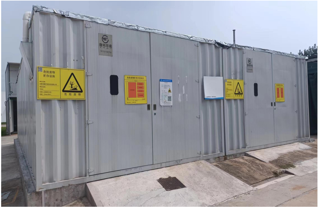
危废暂存间外部照片
