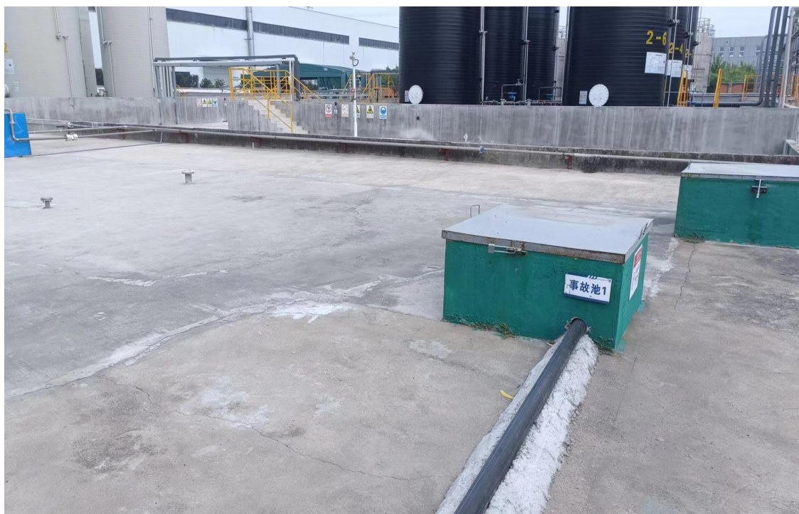
事故池 1 照片（地埋式）
