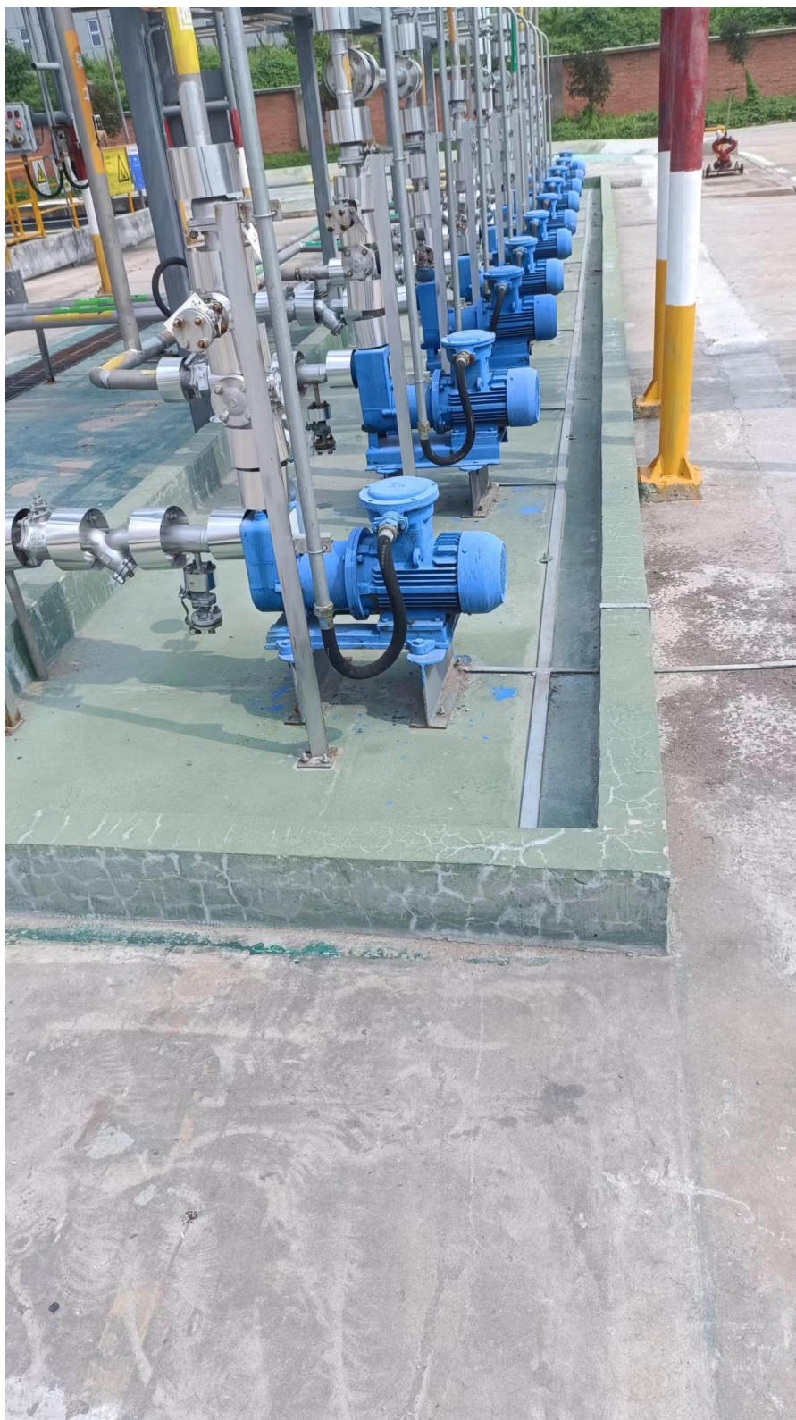
机械泵地面防腐防渗防流失照片（周边设置围堰）
