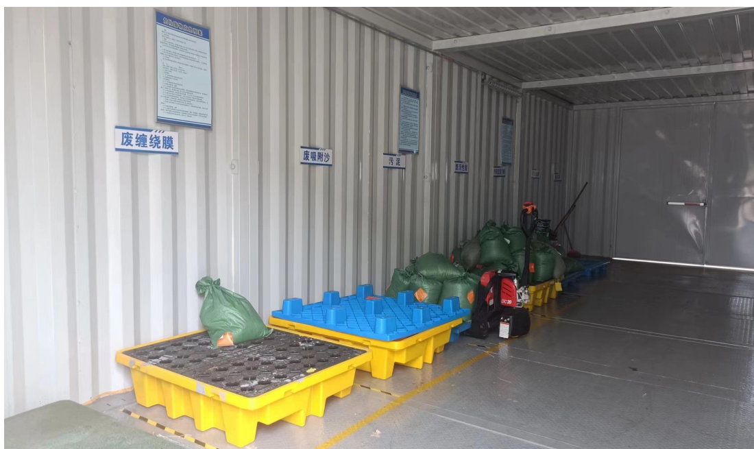
危废暂存间内部照片
