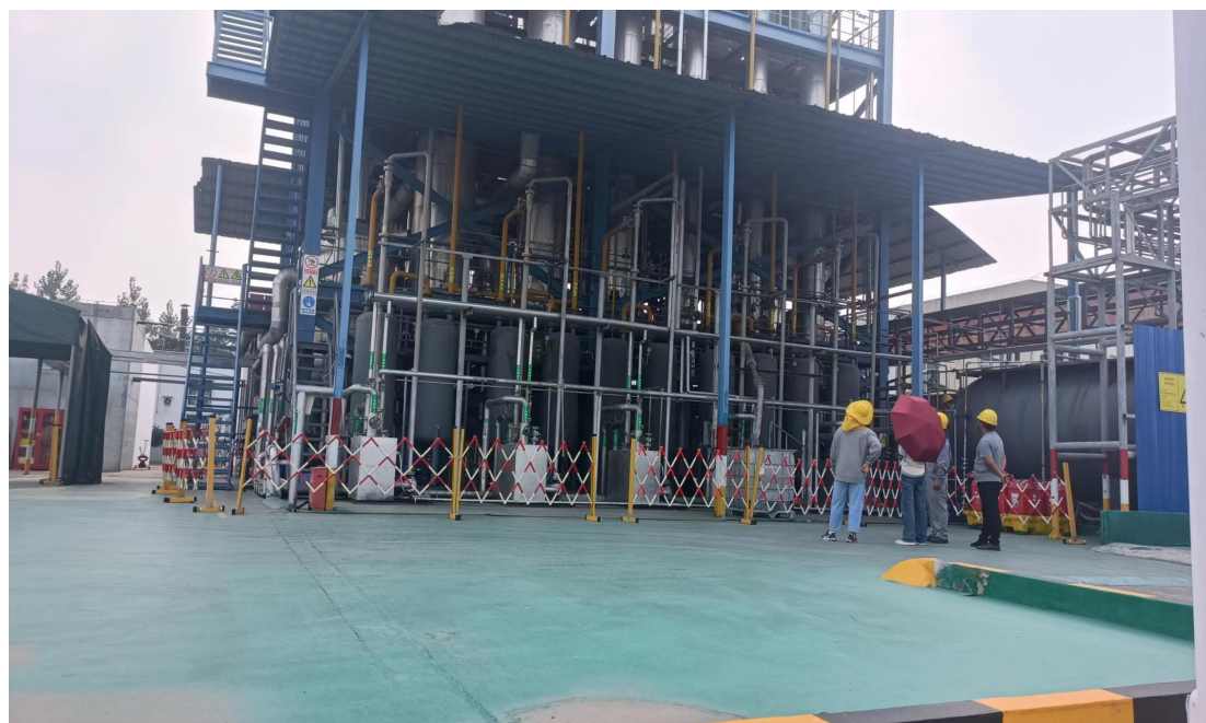
生产装置区地面防腐防渗防流失照片（周边设置围堰）
