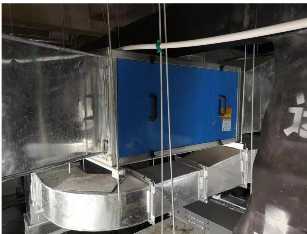
2#片剂生产线压片、包衣工序袋式除尘器及其排气筒 DA006
