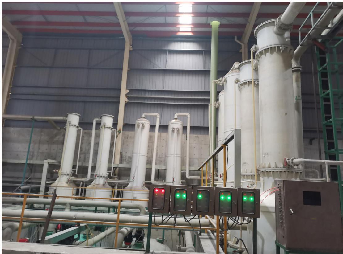
项目废气处理装置及排气筒P2
