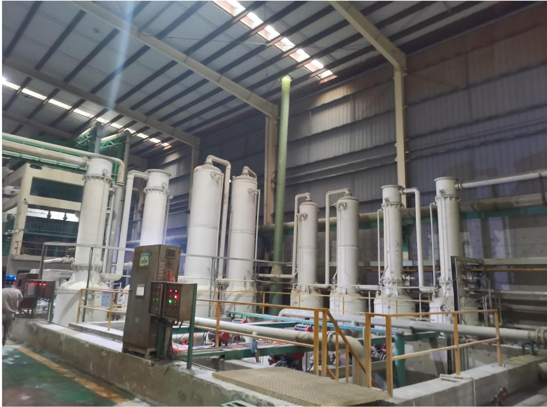
项目废气处理装置及排气筒P1
